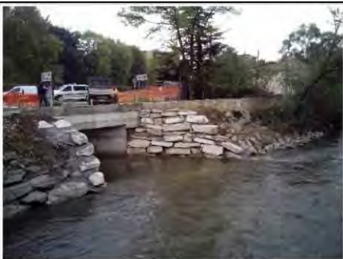
Vista dello sbocco del collettore di bypass immediatamente a valle del ponte durante i lavori di realizzazione del manufatto e di rifacimento dei tratti di argine mediante scogliere e muri [foto Comune di Cologno Monzese]
