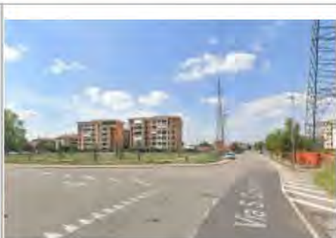
Nuovi quartieri residenziali tra via S. Cristoforo e via Andreani a Brugherio raggiunti dagli allagamenti conseguenti l'esondazione del Lambro a valle dei ponti autostradali [foto Google Street View]
