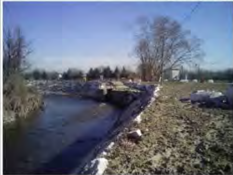
Tratto di argine sinistro a monte del ponte di S. Maurizio al Lambro oggetto di interventi di sistemazione e adeguamento. E' visibile lo scarico delle acque trattate dal depuratore di Monza ubicato più a monte [foto Comune di Cologno Monzese]
