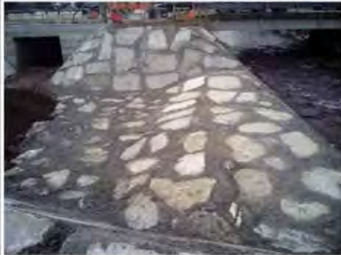
Imbocco del bypass a monte del ponte di S. Maurizio al Lambro durante i lavori di realizzazione: quando la corrente di piena raggiunge il livello della soglia, la portata eccedente viene scaricata nel collettore visibile in sinistra riducendo la pressione sul ponte esistente
