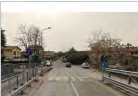
Frazione di S. Cristoforo a Brugherio inclusa negli areali di allagamento per eventi di piena del Lambro con tempi di ritorno duecentennali: la corrente si propaga nei terreni in sponda sinistra a valle dei ponti autostradali fino a raggiungere i quartieri residenziali periferici
