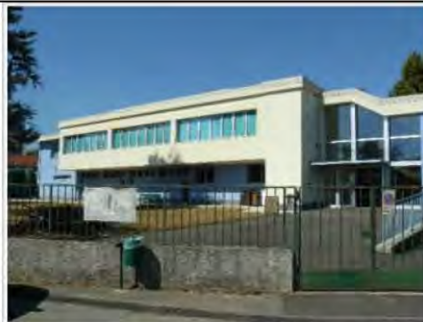
Scuola primaria "U. Foscolo" in via della Repubblica, sede di seggi elettorali, compresa nell'area di esondazione
