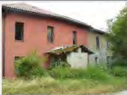
Complesso di Cascina Occhiate e Mulino di Occhiate, nel Comune di Brugherio, con abitazioni e attività produttive agricole raggiunti dall'esondazione del Lambro causata dalla insufficienza idraulica dei ponti autostradali a valle
