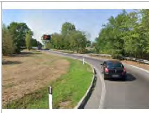
Tratto di viabilità urbana nei pressi dell'ingresso della A52 tra viale Italia e via Edison un'area morfologicamente depressa e pertanto soggetta ad allagamenti in caso di esondazioni del Fiume Lambro [foto Google Street View]
