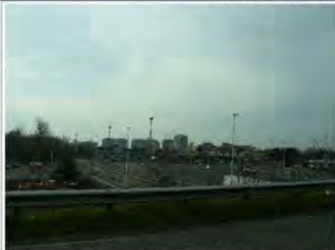
Barriera della Tangenziale Nord a Sesto San Giovanni, interessata dagli allagamenti in caso di esondazioni del Fiume Lambro per eventi di piena duecentennali come quelli attesi in caso di non funzionamento o apertura simultanea degli scarichi della Diga di Pusiano
