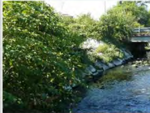
Stato attuale dell'imbocco e del tratto a cielo aperto del collettore di bypass prima di passare al di sotto dell'incrocio tra via S. Maurizio al Lambro e via F. Filzi,
