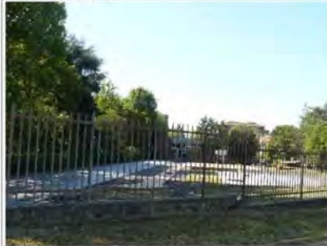
Campi di atletica e di gioco lungo tra via S. Maurizio al Lambro e via Filzi negli spazi esterni della scuola secondaria "E. Toti" visibile sullo sfondo e soggetti ad allagamenti
