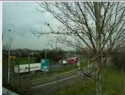
Snodo autostradale tra A52 Tangenziale Nord e innesto con la A4 direzione Venezia nei pressi della barriera di Sesto San Giovanni
