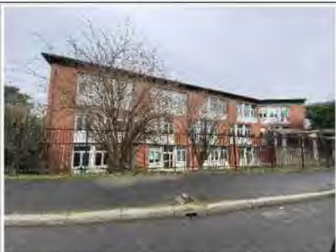
Istituto comprensivo "Anna Frank" di via Mincio a Sesto San Giovanni interessato dagli allagamenti conseguenti alle piene del Fiume Lambro conseguenti al collasso della diga di Pusiano o a manovre di apertura degli scarichi
