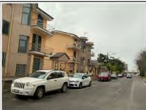
Via Cadore, all'altezza dell'affittacamere Ponte, ribassata rispetto al piano stradale di viale Italia così come la vicina via Friuli, entrambe comprese negli areali di allagamento
