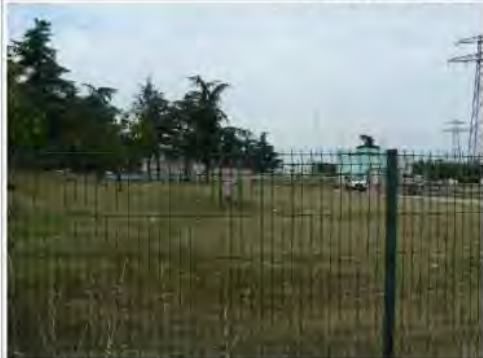
Area dell'impianto di depurazione di Monza di Brianza. Acque esterne agli areali di esondazione per la presenza di rilevati e muri di recinzione impermeabili
