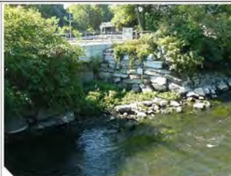
Stato attuale del tratto terminale del collettore che e degli argini in sponda sinistra alla confluenza on Lambro immediatamente a valle del ponte esistente
