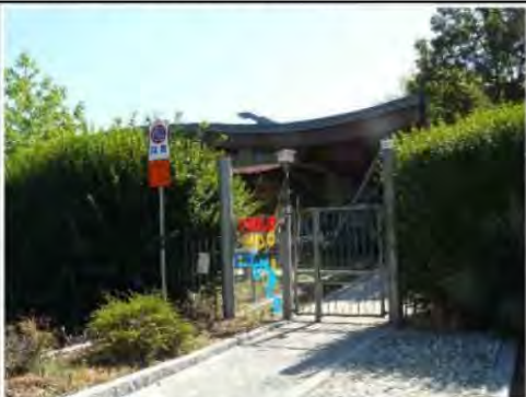
Asilo comunale "C. Mendes" in via C. Battisti raggiunto dagli allagamenti in caso di esondazione del Lambro
