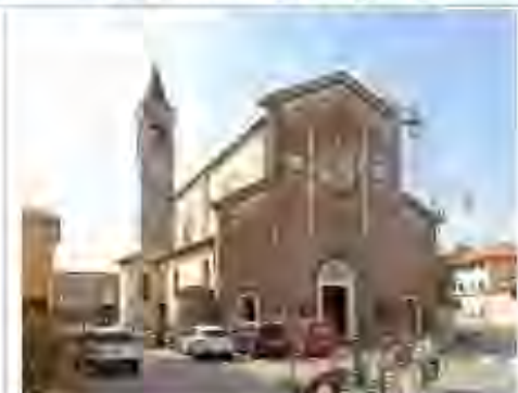
Chiesa di S. Maurizio nella frazione di S. Maurizio al Lambro, storicamente interessata da alleggerimenti a causa dell'esondazione del Lambro
