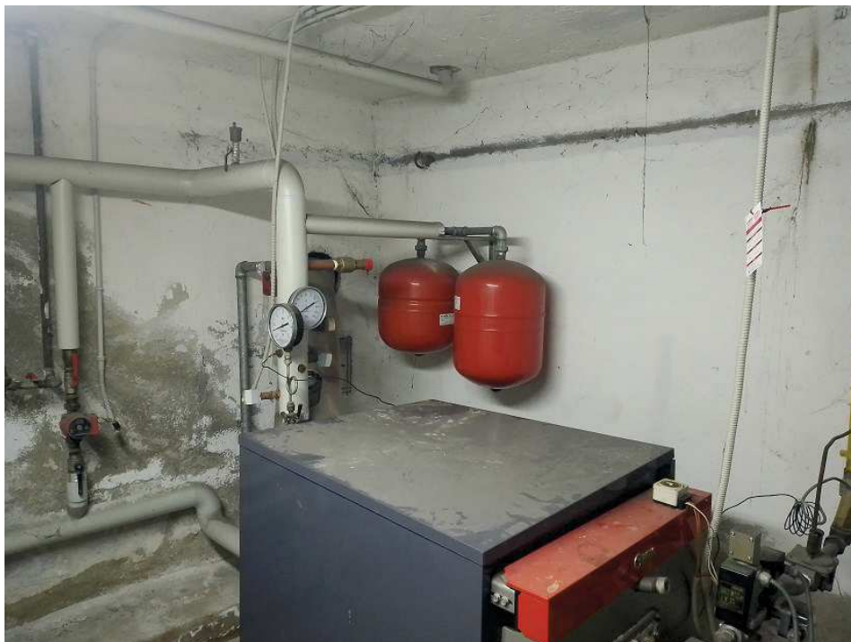
Immagine 13: Generatore di calore da sostituire
