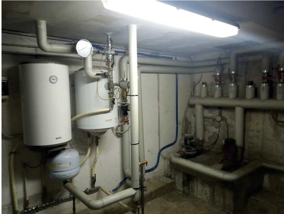
Immagine 12: Centrale termica da ripristinare
