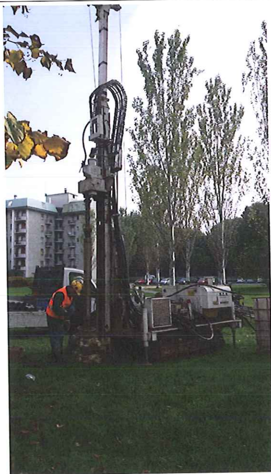
Foto 3: esecuzione sondaggio S2 di profondità 12 m da p.c., realizzato con il metodo di perforazione a carotaggio continuo; in tal modo è risultato possibile osservare direttamente e descrivere la tipologia di sedimenti incontrati lungo la verticale di scavo (vedi fig. 4, 5 e 6)
