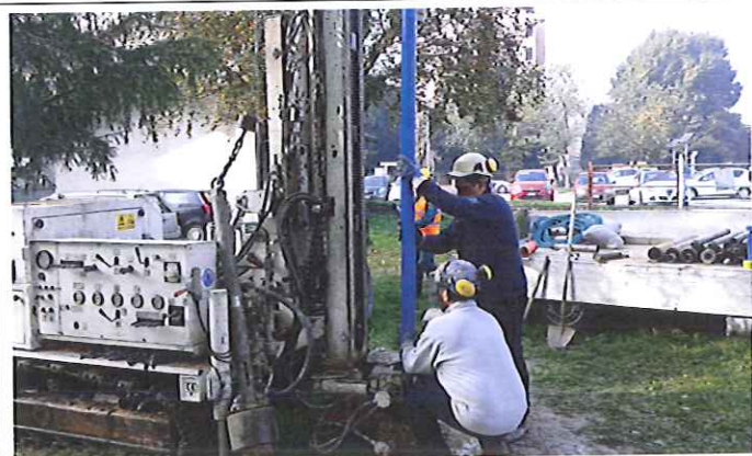
Foto 11: inserimento di tubazione in PVC all'interno del foro di sondaggio al fine di realizzare un piezometro
