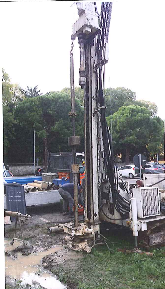
Foto 12: esecuzione prova SPT
