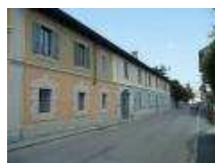
Villa Somaglia, Balconi - complesso Brugherio (MB)
