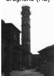
Torre Campanaria di S. Bartolomeo Brugherio (MB)
