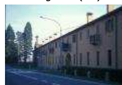
Cascina S. Ambrogio - complesso Brugherio (MB)
