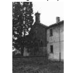
Chiesa di S. Ambrogio Brugherio (MB)
